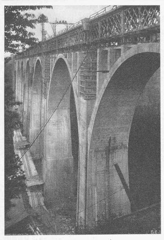
Abb. 6. Ausgeschalte grosse Gewölbe mit fertig betonierten Aufbauten auf Gehsteghöhe (22. Mai 1926)
