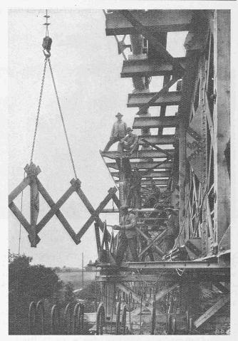
Abb. 10. Abbruch der flussabwärts liegenden Tragwand des eisernen Ueberbaues.
