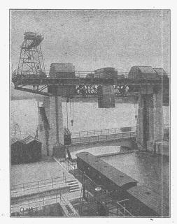
Fahrbarer Montagebockkran, Dammbalkentransportkran und Doppelwindwerke, Kraftwerk Augst-Wyhlen-
