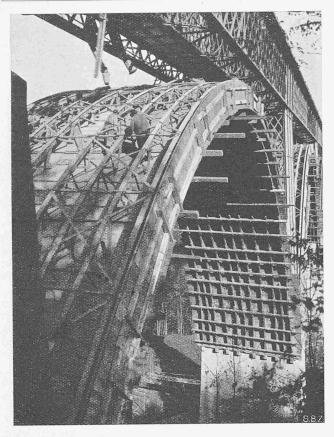
Abb. 5. Melan-Bogen mit angehängter Schalung.
