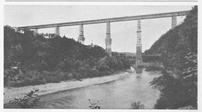
Abb. 2. Gesamtbild der alten Gitterbrücke. Beginn der Einbetonierung der eisernen Pfeiler über den gemauerten Sockeln (11. August 1925).
