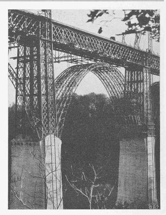
Abb. 4. Fertig montierte Melanbogen, links Montagebeginn (Aufn. 26. Okt. 1925). Hängegerüste mit dem Gitterträger, längs der Pfeilergerüste die Betonaufzüge. Melan-Konstruktion von Löhle & Kern A.-G., Zürich.
