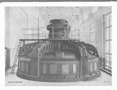
Hydroelektrische Zentrale Mühleberg an der Aare der Bernischen Kraftwerke A-G, Bern. Einer der gelieferten sechs Dreiphasen-Wechselstrom-Generatoren von je 8000 kVA, 16000|17600 V, Frequenz 40|50, Drehzahl 133|167.
