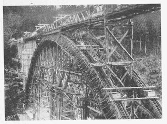
Abb. 10. Der Bogen während der Betonierung.
