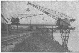
Hochbahn-Drehkran für Greiferbetrieb. Halbportal-Drehkran für Greifer- und Tragkraft 4 t, Ausladung 26 m, Hoch-bahn 200 m lang. Geliefert für den Rheinhafen Basel
