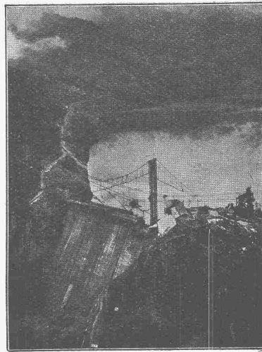
Bleichert-Kabelkran beim Talsperrenbau
