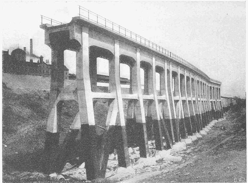
Abb. 4. Stockwerkrahmen der Stuttgarter Geleisekreuzungen, vor der Einfüllung.
