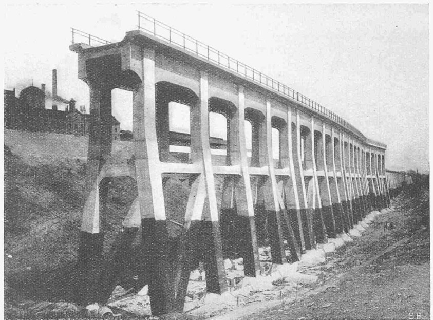
Abb. 4. Stockwerkrahmen der Stuttgarter Geleisekreuzungen, vor der Einfüllung.
