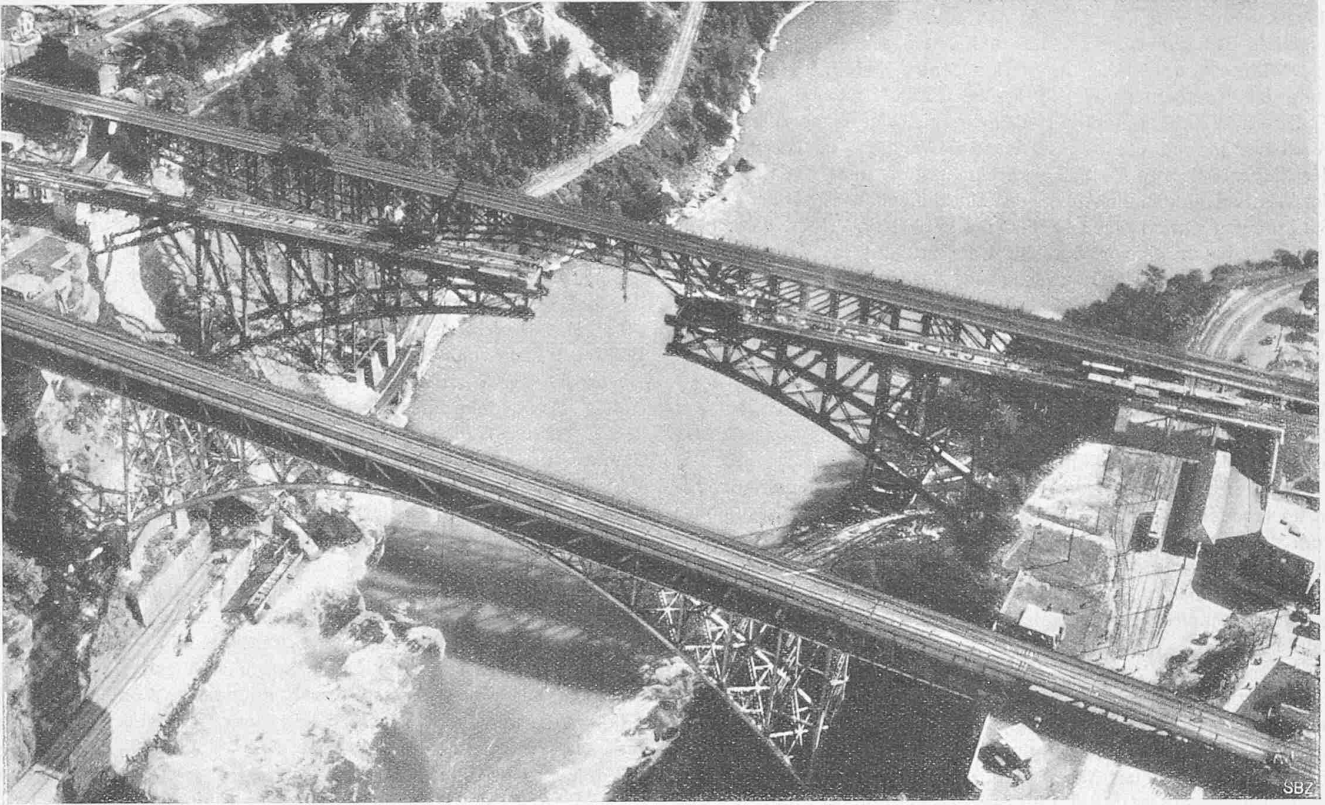
Abb. 1. Fliegeraufnahme der Niagarabrücken, von der kanadischen Seite aus flussabwärts gesehen. Im Vordergrund die Bogenbrücke der Grand Trunk R. R. In der Mitte die neue Bogenbrücke der Michigan Central R. R., kurz vor Montageschluss. Im Hintergrund der Gerberträger der gleichen Bahn, nach Inbetriebnahme der neuen Bogenbrücke abgebrochen (vergl. nebenstehende Abb. 2).
