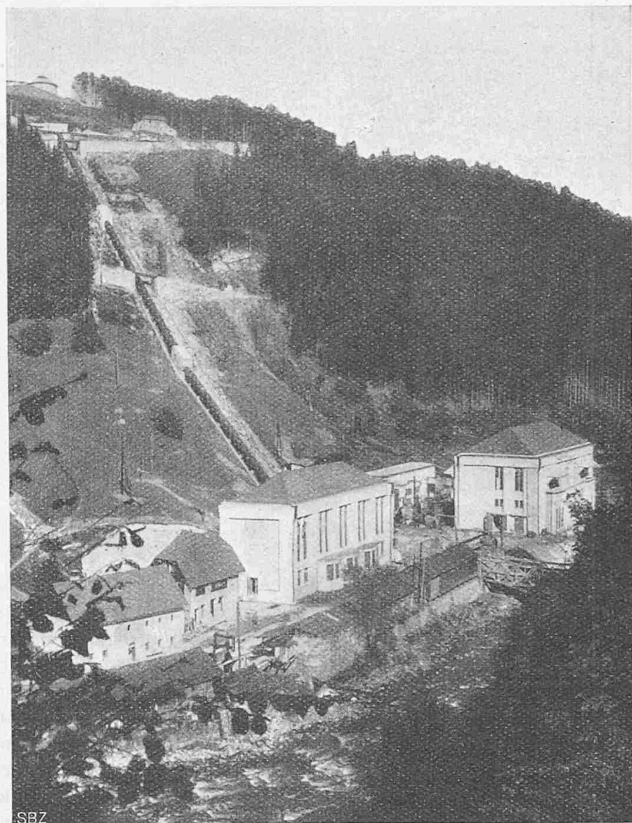
Abb. 5. Wasserschloß, Druckleitung und Zentrale.
