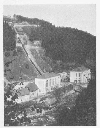
Abb. 5. Wasserschloss, Druckleitung und Zentrale.
