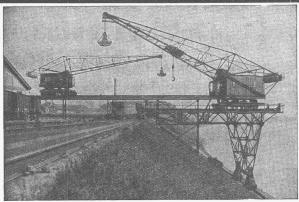
Hochbahn-Drehkran für Greiferbetrieb. Tragkraft 4 t, Austadung 26 m, Hochbahn 200 m lang. Geliefert für den Rheinhafen Basel
