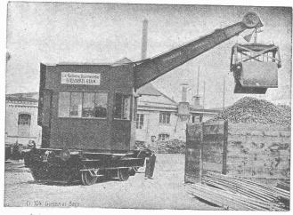
Lokomotivdrehkran mit Akkumulatorenbetrieb, 5 Tonnen Tragkraft.
