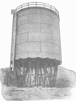
Genieteter Laugenbehälter von 1000 m3 bezw. 1350 Tonnen Inhalt, 10,8 m Durchmesser, 12 m Höhe, mit Spezialbodenkonstruktion.
