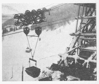
Abb. 7. Kabelkran-Laufkatze mit Aushubkübel.
