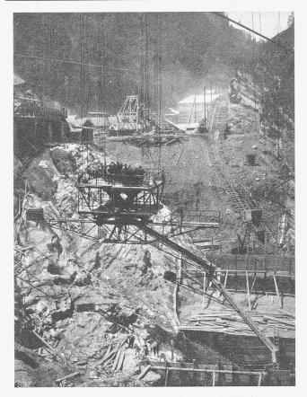
Abb. 12. Beton-Giessvorrichtung am Kabelkran im Wäggital.
