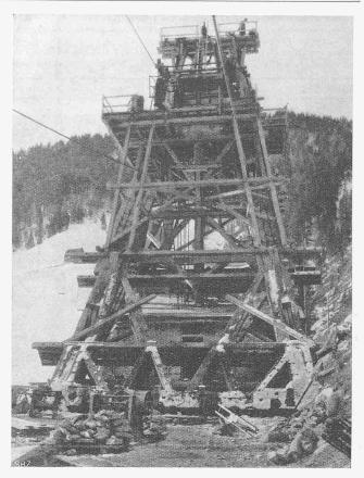
Abb. 10. Ansicht des hölzernen Abspannturms im Wäggital.
