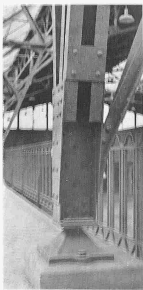
Abb. 13 u. 14. Festes und bewegliches Auflager der Dachbinder.
