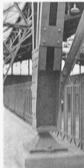
Abb. 13 u. 14. Festes und bewegliches Auflager der Dachbinder.
