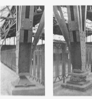
Abb. 18 u. 14. Festes und bewegliches Auflager der Dachbinder:
