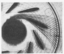
Abb. 9. Strömungen zwischen Leitradschaufeln: geformte Schaufeln, ohne Zeitkurven.
