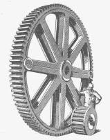
Einzelantrieb eines Altpapter-Kochers mit Lenix- und Stirnräder-Reduktionsgetriebe.
