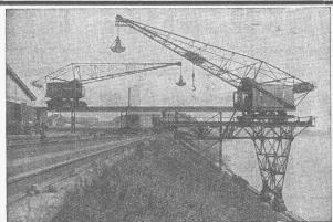
Halbportal-Drehkran für Greiferbetrieb. Halbportal-Drehkran für Greifer- und Tragkraft 4t, Ausladung 26 m, Hochbahn 200 m lang. Halbportal-Drehkran für Greifer- und Stückgutbetrieb, Tragkraft 4t bei 20 m Ausladung. Geliefert für den Rheinhafen Basel
