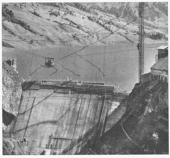
Abb. 1. Giessrinnen und Kabelkran zur Betonierung der Wäggital-Staumauer am 6. September 1924. (Phot. Wolf-Bender, Zürich.)
