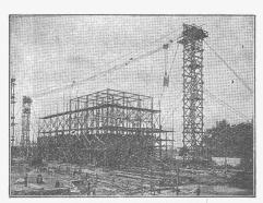
Bleichert-Kabelkran für Hochbauten
