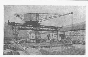
Hochbahn-Drehkran für Greiferbetrieb. Halbportal-Drehkran für Greifer- und Tragkraft 4 t, Ausladung 26 m, Hoch-bahn 200 m lang. Geliefert für den Rheinhafen Basel
