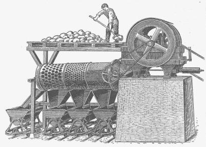
Steinbrecher mit Sortiertrommel.
