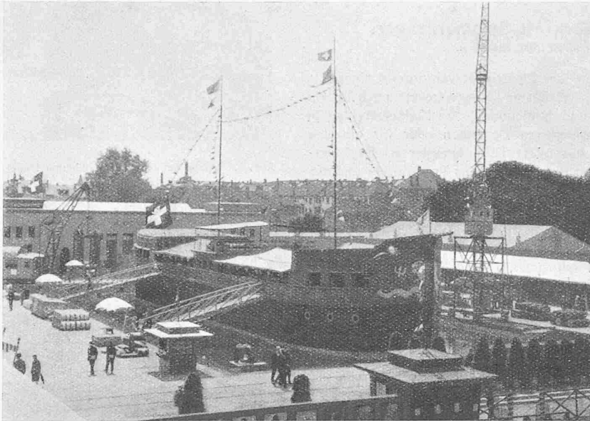
Abb. 3. Der Basler „Vergnügungshafen“, von der Verbindungsbrücke aus.
