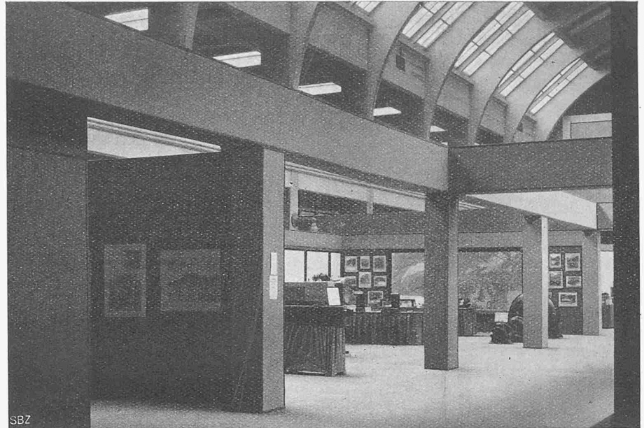
Abb. 1. Raum der Ecole d'Ingénieurs de Lausanne in der Halle II.
