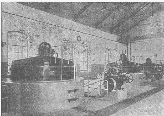
zifische Drehzahlen von 893 pro Minute, bei Gefälle v. 3,3 m u. erreichten Wirkungsgraden bis 91,3%.
