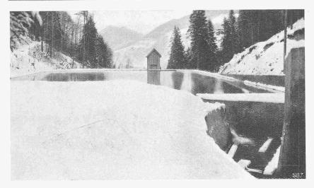
Abb. 5. Ausgleichbecken. Rechts Einlaufrechen der Haslenbach-Umleitung.
