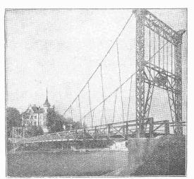
Bleichert-Seilhängebrücke von 80 m Spannweite
