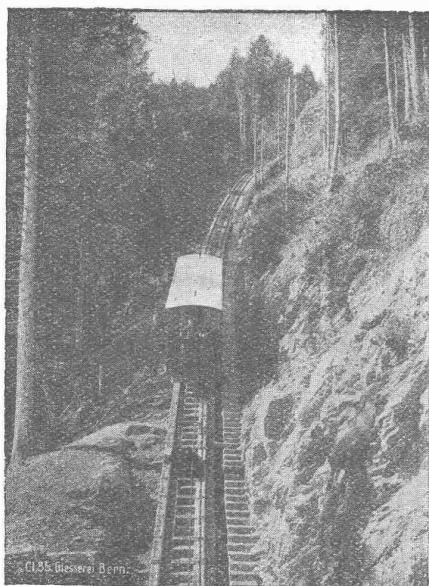
Seilbahn Niesen, I. Sektion, maximale Steigung 66 %.
