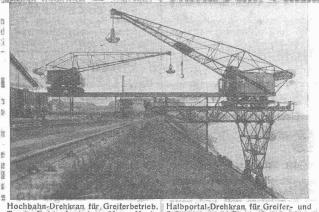
Hochbahn-Drehkran für, Greiferbetrieb. Tragkraff 4 t, Ausladung 26 m, Hoch-bahn 200 m lang. Geliefert für den Rheinhafen Basel.
