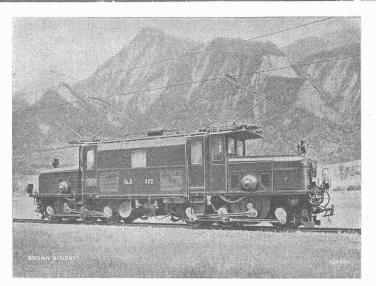
Einphasenstrom-Lokomot.ve, Typ C-C für die Rhätische Bahn  $2\times600$  PS,  $10\,000$  Volt Fahrdrahtspannung, Frequenz  $16^{\,2}/_3$  Geschwindigkeit 30 bis 45 km/h, Spurweite 1 m.
