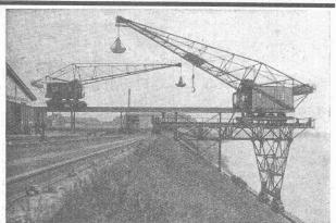
Halbportal-Drehkran für Greiferbetrieb. Halbportal-Drehkran für Greifer- und Stückgutbetrieb, Tragkraft 4t bei 20 m Ausladung, 8 t bei 10 m Ausladung.
