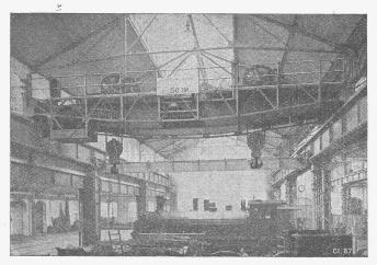
Lokomotivhebekran von 80 Tonnen Tragkraft, in den Reparaturwerkstätten der S. B. B. in Zürich.
