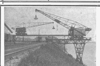
Hochbahn-Drehkran für Greiferbetrieb. Halbportal-Drehkran für Greifer- und Tragkraft 4 t, Ausladung 26 m, Hoch-bahn 200 m lang. Ausladung, 8 t bei 10 m Ausladung. Geliefert für den Rheinhafen Basel
