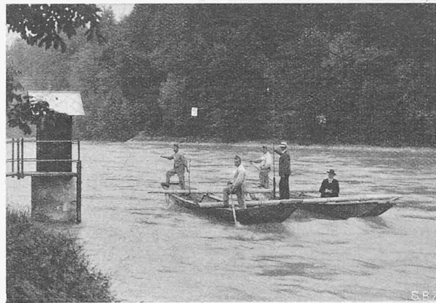
Abb. 6. Flügelmessung mit Stangenführung. (Aare bei Bern).
