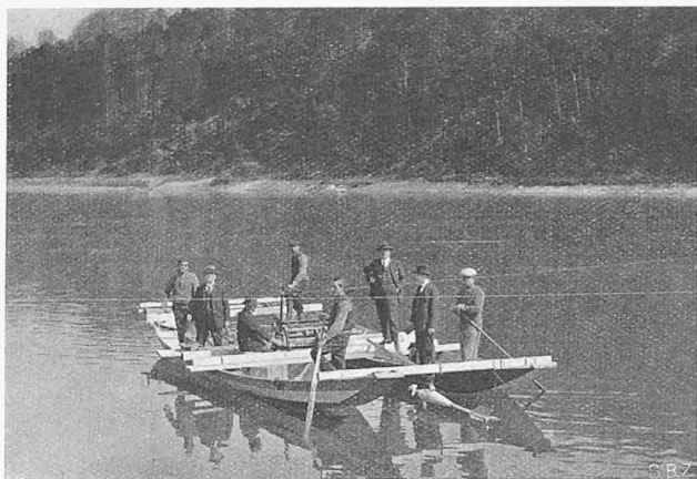
Abb. 7. Neuer Hochwasser-Messflügel (Rhein im „Nol“).
