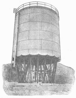
Genieteter Laugenbehälter von 1000 m3 bezw. 1350 Tonnen Inhalt, 10,8 m Durchmesser, 12 m Höhe, mit Spezialbodenkonstruktion.
