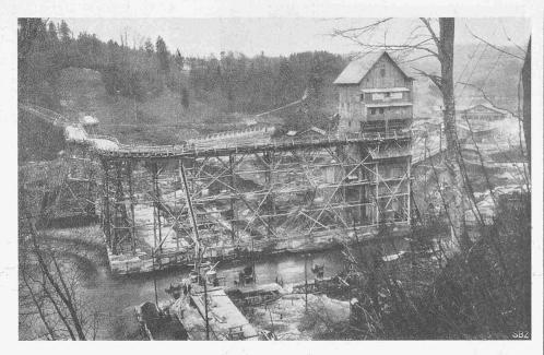
Abb. 41. Desgl. zweite Bauetappe; Silo und Betonieranlage, am 28. Dezember 1918.
