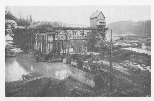
Abb. 42. Wie oben, Bauzustand am 19. Nov. 1919, unmittelbar vor Einschwimmen des Caisson XI.
