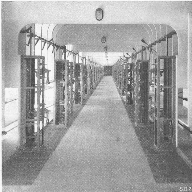
Abb. 30. Sammelschienen-Systeme II und I im Erdgeschoss.
