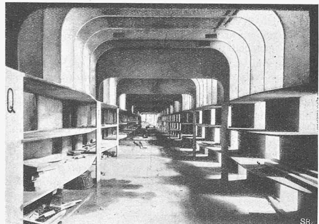
Abb. 29. Betonwände mit Tablaren im Schalthaus (im Bau).
