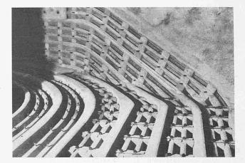
Abb. 21. Landseitiges Ende des Hochspannungs-Kabelkanals
