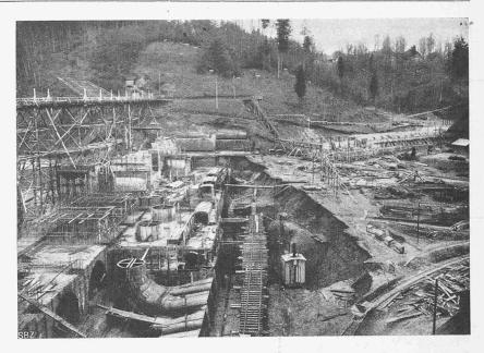
Abb. 23. Maschinenhaus im Bau, vorn Aspiratoren-Schalung.
