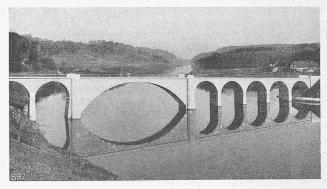
Abb. 6. Hinterkappelenbrücke. Hauptöffnung 44,3 m, Nebenöffnungen 12 m.
