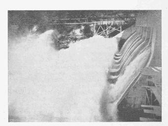
Abb. 12. Wirkung der Schikanen bei 240 m3/sek Abfluss.
