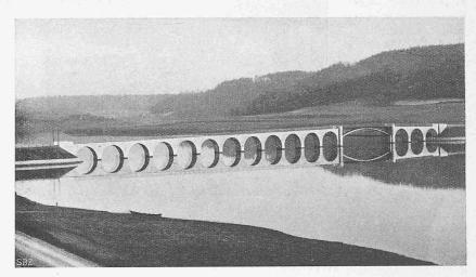
Abb. 5. Wohleibrücke, gewölbte Oeffnungen 9 m weit, eiserner Zweigelenkbogen 30 m weit.
