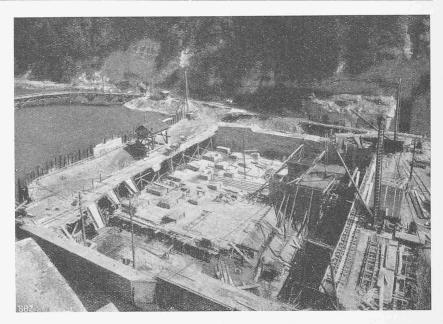
Abb. 11. Blick schräg flussabwärts (gegen das rechte Ufer) auf das Stauwehr während des Baues. Betonierung der untern Schikanen.
