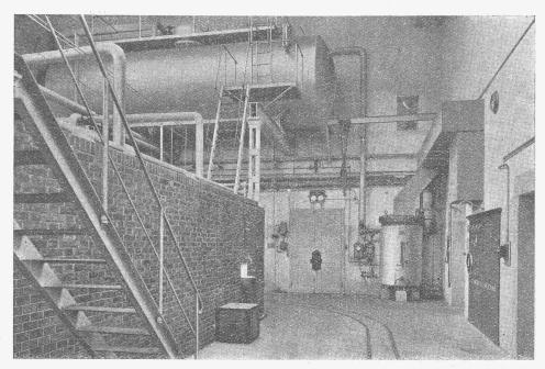
Elektroden-Dampf-kessel- u. Speicher-Anlage im Frauen-Spital Basel.
