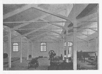
Abb. 4. Inneres obiger Fabrik Pirelli. Pfeilerabstand 9 m. Zugbänder einbetoniert (vergl. Tafel 22 oberes Bild).
