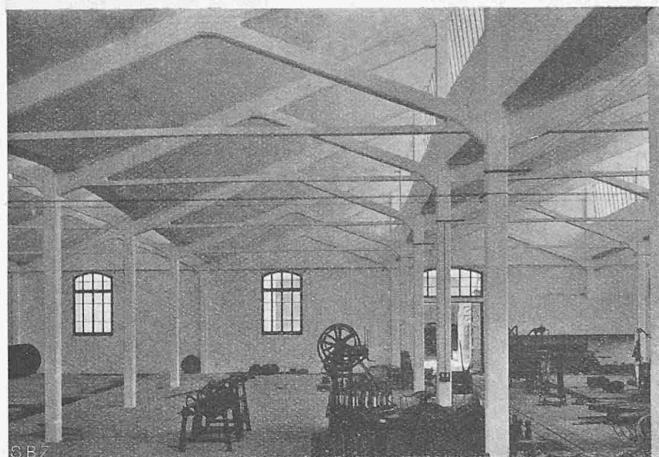
Abb. 4. Inneres obiger Fabrik Pirelli. Pfeilerabstand 9 m. Zugbänder einbetoniert (vergl. Tafel 22 oberes Bild).
