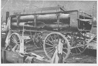
Abb. 2. Explosion eines Wasserstoffbehälters in Altdorf, 1921.
