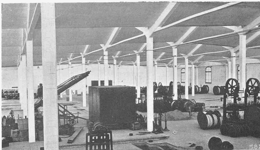
Kabelfabrik von Pirelli in Villa- nueva, Spanien
