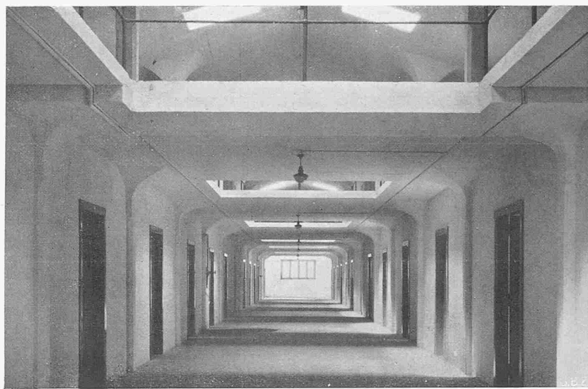
Obergeschoss für 1500 kg/m 2 — Vorn Verstärkung längs einer Dehnungsfuge
