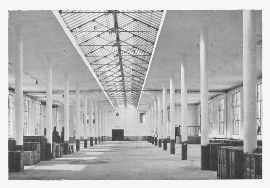
Runde Säulen, auskragende Platte zur Aufnahme des Oberlichts
