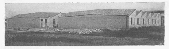
Abb. 3. Kabelfabrik Pirelli in Villanueva (Spanien), erbaut 1925. Reiner Zweckbau, Aussenwände Backstein.
