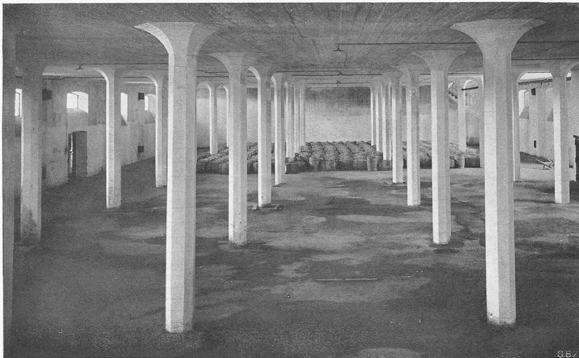
Zwischengeschoss, Nutzlast 1100 kg/m 2
