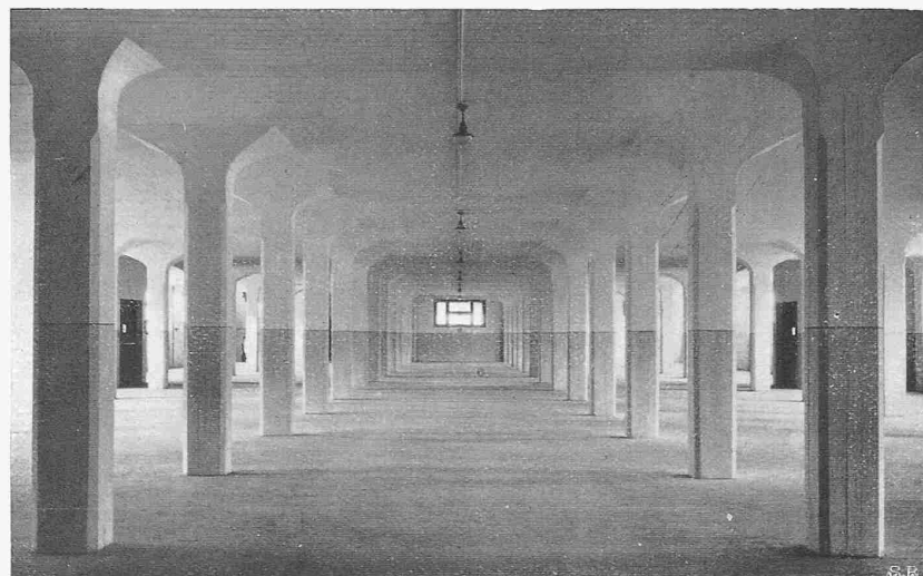
Mittelgeschoss Nutzlast 2000 kg/m 2
