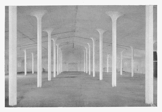
Dachgeschoss für 1100 kg/m³ Nutzlast
