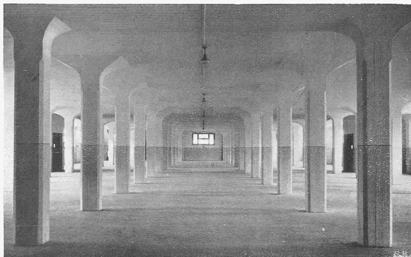
Mittelgeschoss Nutzlast 2000 kg/m 2
