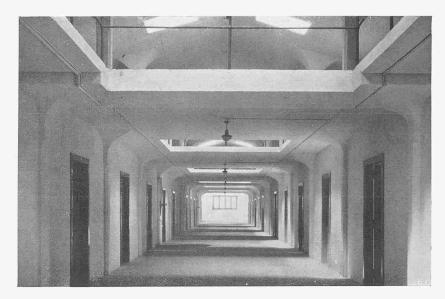
Obergeschoss für 1500 kg/m² — Vorn Verstärkung längs einer Dehnungsfuge
