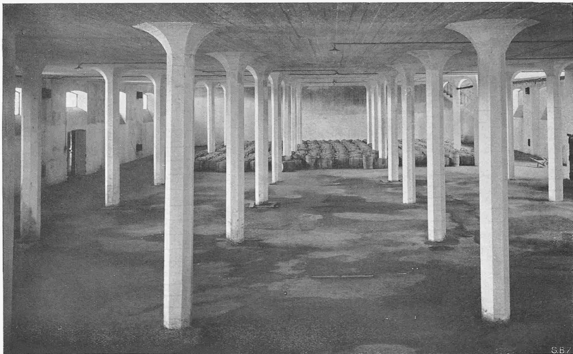
Zwischengeschoss, Nutzlast 1100 kg/m 2
