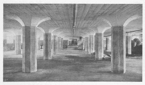
Abb. 5. Pilzdecken für 2000 kg/m² im Lagerhaus Giesshübel der Zürcher Lagerhausgesellschaft, Erbaut 1910 durch Maillart & Cie. in Zürich.
