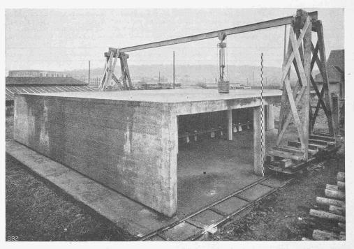
Abb. 3. Zweites Pilzdecken-Versuchsobjekt von Maillart & Cie. Bewegliche Einzellast von 1000 kg (Bleigewicht).
