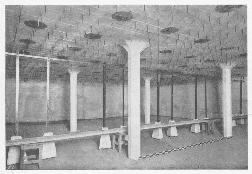
Abb. 4. Zweites Pilzdecken-Versuchs-Objekt von Maillart & Cie. Untersicht mit Messpunkten.
