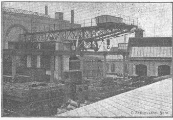
Hof-Lauikran, Tragkraft 15 Tonnen, Länge 23 m, mit einseitigem festen Ausleger.
