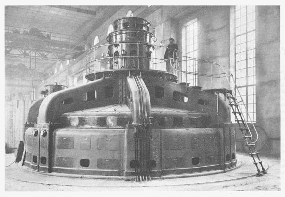
Fig. 15. Alternateur triphasé de 7000 kVA, 83,3 tours, sous 11000 Volts et 50 périodes, des Usines Schneider & Cie. à Champagne-sur-Seine. (Cette figure a été réduite à la même échelle que celles des roues des turbines parues dans le numéro précédent.)
