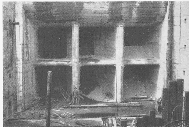
Fig. 11. Entrée de la bache spirale d'une turbine des Ateliers des Charmilles.
