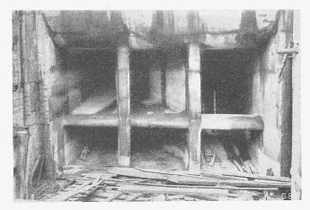
Fig. 10. Entrée de la bâche spirale d'une turbine d'Escher Wyss & Cie.
