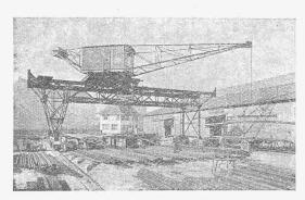
Verladebrücke mit fahrbarem Drehkran, 4 t Tragkraft, 15 m Ausladung, für einen Eisenlagerplatz.
