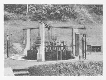
Abb. 121. Belastungswiderstand, mit den Elektroden für Drehstrom.
