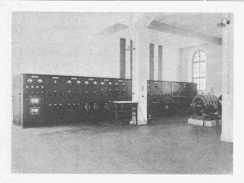
Abb. 120. Schalttafel der Eigenverbrauch-Anlage.
