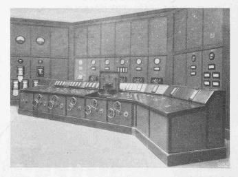
Abb. 118. Schaltpult und Schalttafel für die Generatoren usw.
