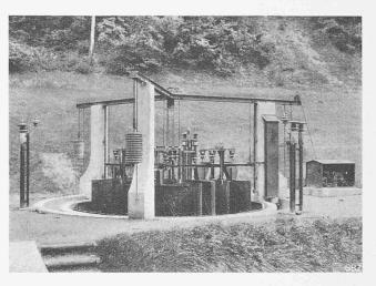
Abb. 121. Belastungswiderstand, mit den Elektroden für Drehstrom.
