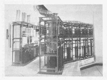
Abb. 119. Verteilraum unter dem Transformatoren-Schaltpult.
