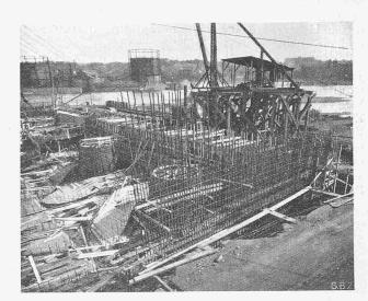
Abb. 4. Fundament des Maschinenhauses, im Bau.
