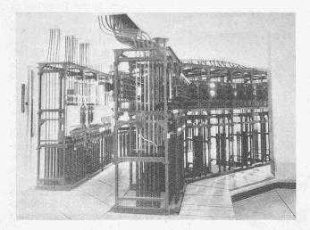
Abb. 119. Verteilraum unter dem Transformatoren-Schaltpult.
