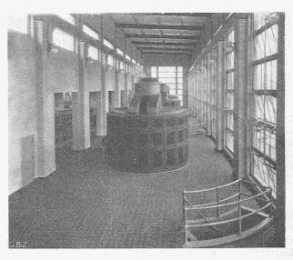
Abb. 5. Maschinensaal des Kraftwerks Green Island bei Albany, N. Y. Vier Einheiten von 2030 PS,  $H=3.96\ m,\ 80\ Uml/min.$
