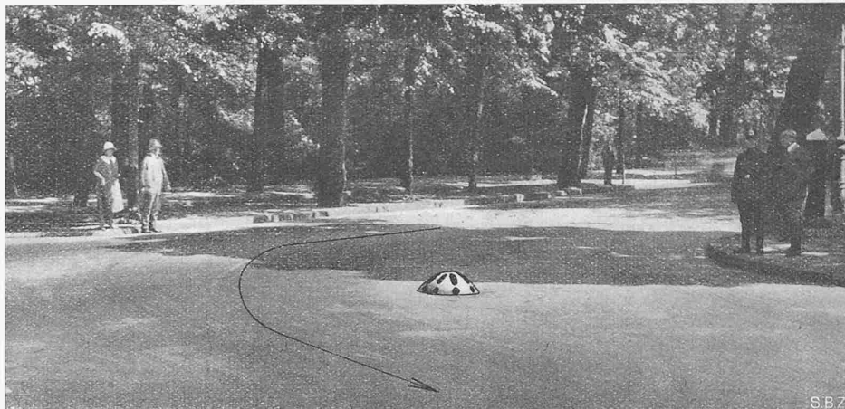
Abb. 3. „Schildkröte“ an der Einmündung einer Nebenstrasse in die stark befahrene Tiergartenstrasse in Berlin.
