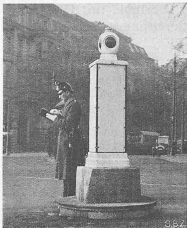
Abb. 5. „Aga“-Gasakkumulator-Blinklicht.
