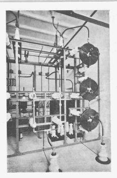
Abb. 111. Schutzdrosselspulen 66 kV der Transformatoren.
