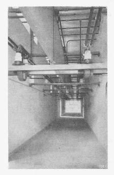
Abb, 109. Sammelschienen für 15 kV.
