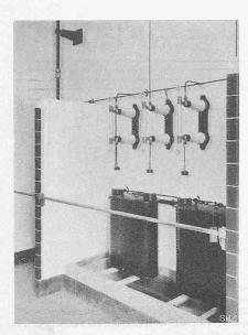
Abb. 106. Messwandler der Einphasen-Generatoren.
