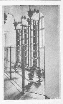
Abb. 115. "Oxyd-Film-Arrester" der 60 kV-Kabel.
