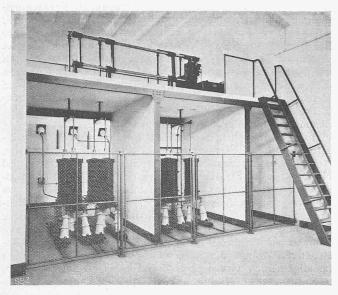
Abb. 112. Topfölschalter für 66 kV der Transformatoren.
