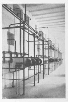
Abb. 108. Trennmesser für 15 kV.
