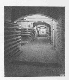
Abb. 116. Leitungsgang für Mess- und Steuerkabel.
