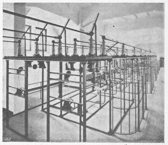
Abb. 113. Umleitschienen für 66 kV.
