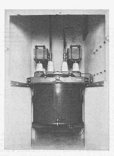
Abb. 107. Oelschalter der Einphasen-Generatoren.
