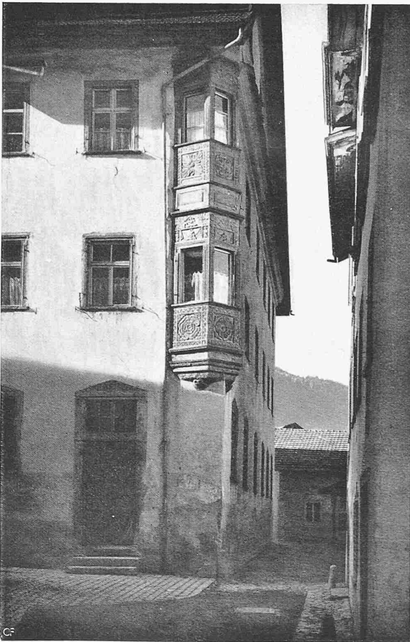
„CASA GRONDA“. ERBAUT 1677. ERKER NORDOST-ECKE.
