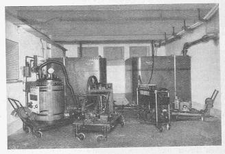
Abb. 99. Oelreinigungsanlage und Oelbehälter.
