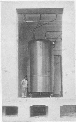
Abb. 97. Nach aussen geöffnete Transformatorzelle des Kraftwerks Amsteg.
