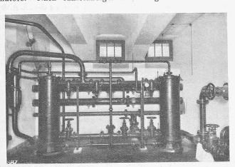
Abb. 98. Oelkühleinrichtung eines Transformators.
