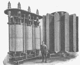
Drehstrom-Oeltransformator von 13000 kVA, mit Oelkühlung 7000J/13500 Volt
