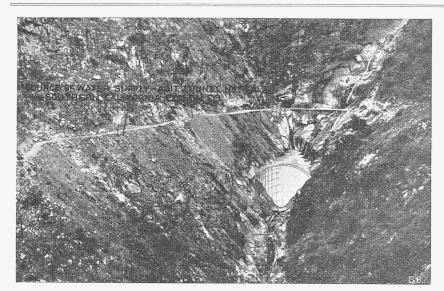
Abb. 2. Versuchs-Gewölbe-Staumauer am Stevenson-Creek, Californien.
